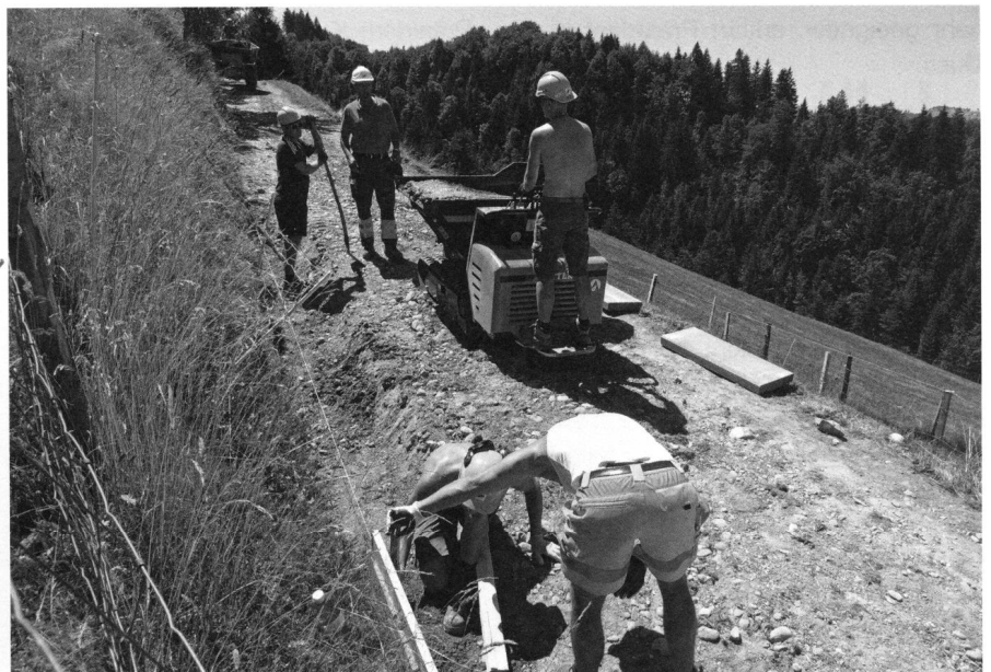
Beginn des Strassenbaus
