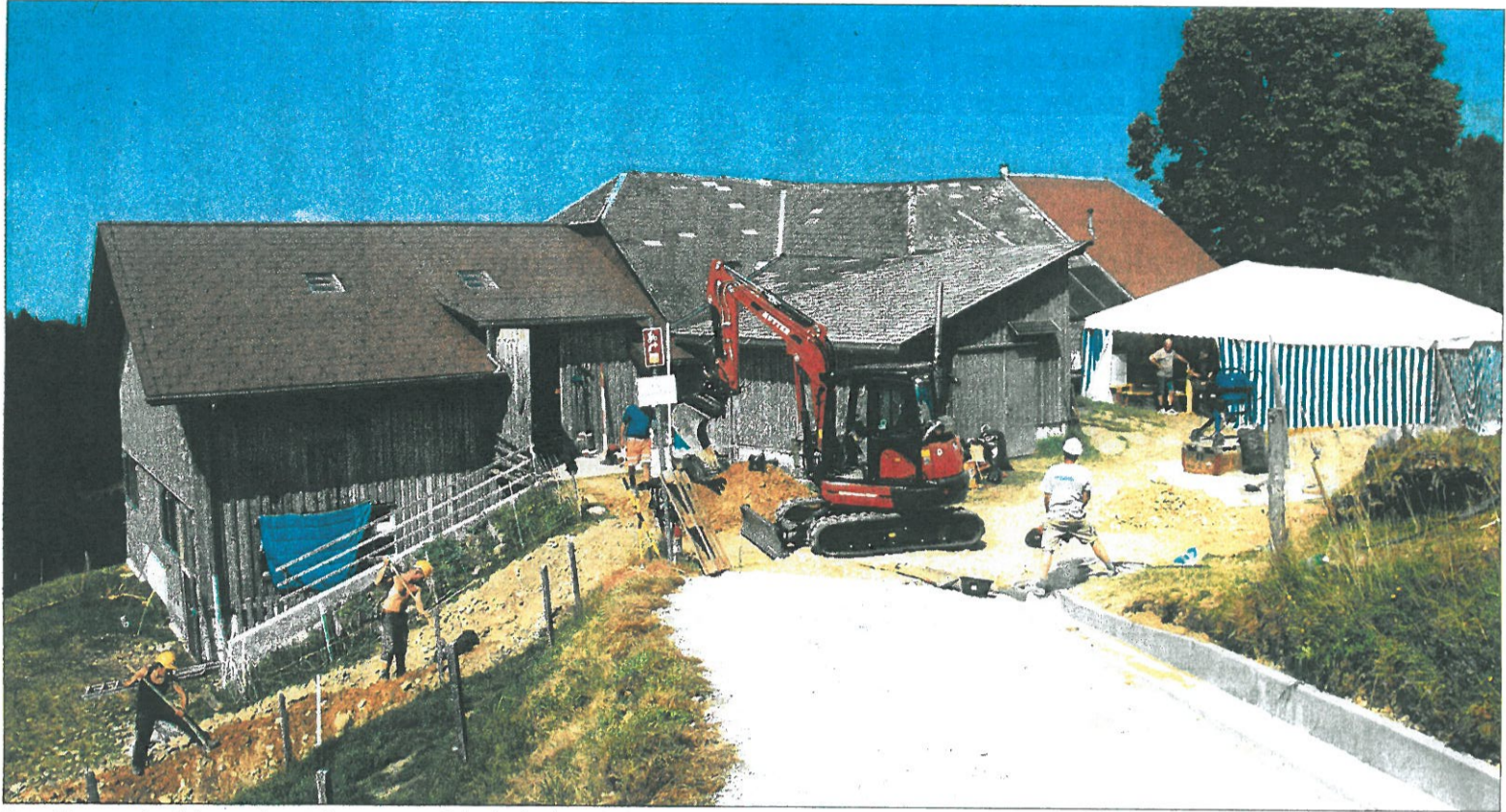
Egger Turner schaufeln gerade an einem neuen Schacht für den Bio-Bauernhof «Chrutose» im Napfgebiet. Sie wohnen und arbeiten dort während einer Woche.
